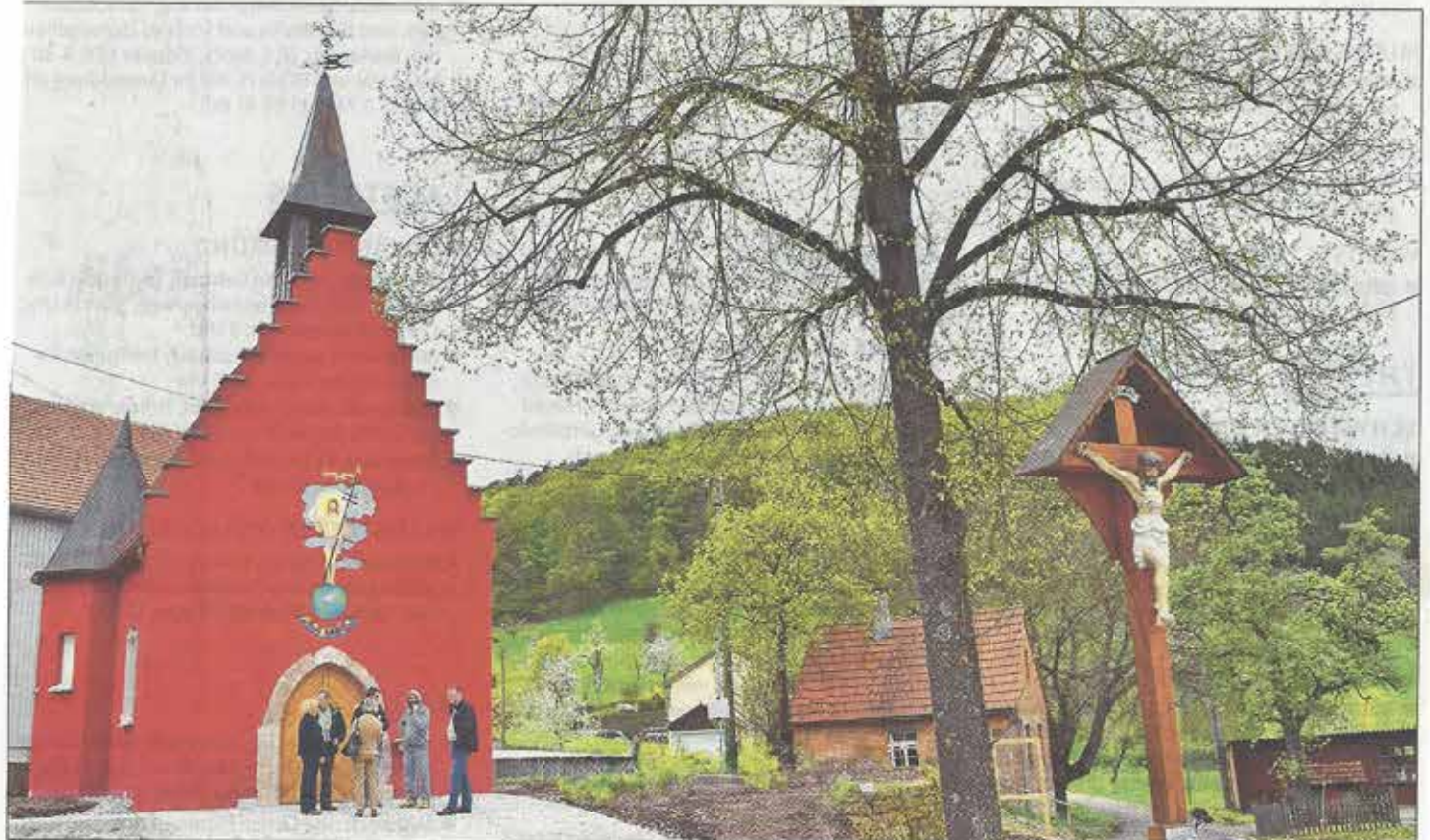
Nach drei Jahren ist das Werk vollbracht. Und für das Einweihungsfest am morgigen Feiertag steuert Petrus sonnige Wetteraussichten bei. Hier das neue Wahrzeichen von Herdtlinsweiler, die Christi-Himmelfahrt-Kapelle, mit dem alten Wegkreuz vor der Kulisse der aufblühenden Natur. Foto: hs
