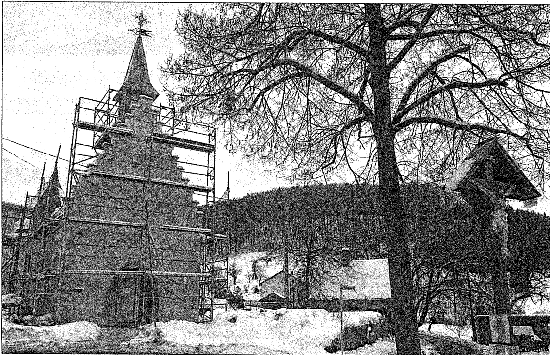
Rechtzeitig vor dem Wintereinbruch haben die ehrenamtlichen Handwerker und Baumeister den Kapellenneubau dicht gemacht. In den nächsten Wochen kann im Innern weiter gearbeitet werden. (Foto: Laible)
