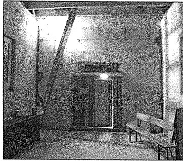
Der Eingangsbereich zur Kapelle von Innen.
